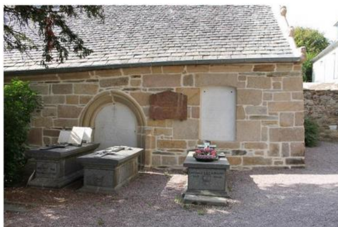
Source : L2 vue de l'ossuaire restauré.
